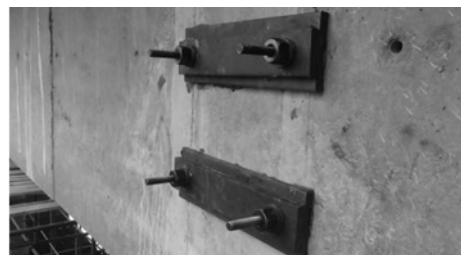
图7 预应力钢棒加固施工
