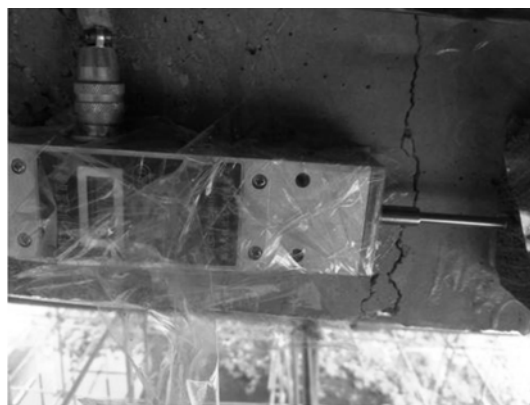
图 9 张拉过程裂缝宽度监测
