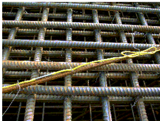
图2 光纤光栅温度传感器
