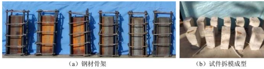
图2 型钢混凝土短柱试件的制作过程
